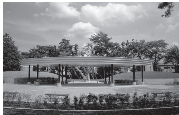
小平霊園合葬埋蔵施設 (1 号基・2 号基)
