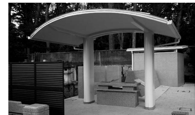
染井霊園立体埋蔵施設 (第 3 区)
