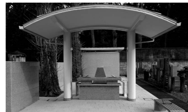
染井霊園立体埋蔵施設 (第 2 区)
