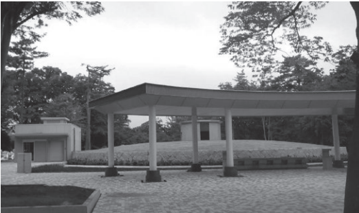
〈八柱霊園合葬埋蔵施設〉
